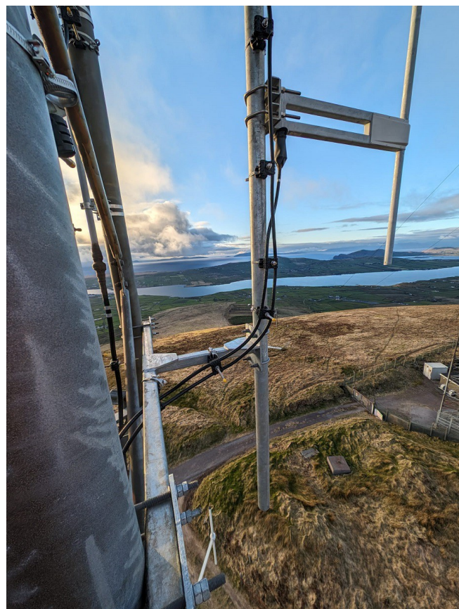
Radio Kerrys sendemast i Kilkeveragh i et sydvestlige Irland. Herfra sendes med 3 kW på 96.2 MHz.
